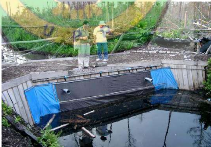
Gambar 2.3 Sekat Isi yang Dibangun oleh Yayasan MAWAS - BOS Disalah Satu Saluran Eks-PLG, Kalimantan Tengah
